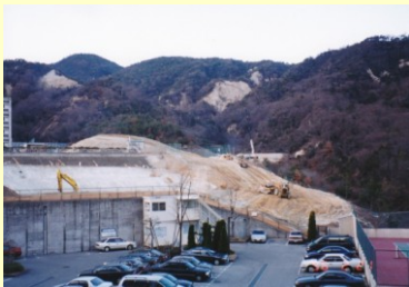
震災事後の宝塚西高法面工事
