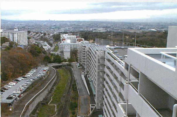
白瀬川周辺に立ち並ぶ8つのマンション群
